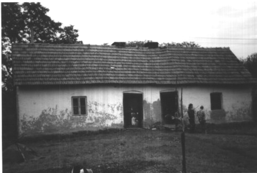
49. Hirtenhaus, Ansicht vom Innenhof
