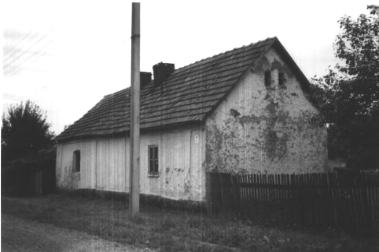
48. Hirtenhaus, ältestes Wohngebäude Pauschings, Ansicht von der Straßenseite
