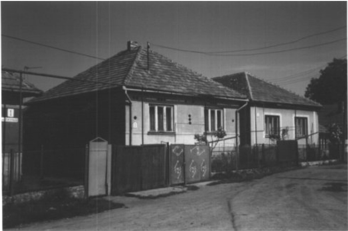
121. Engelsa-Straße Nr. 3 und 5 Richtung Friedhof
