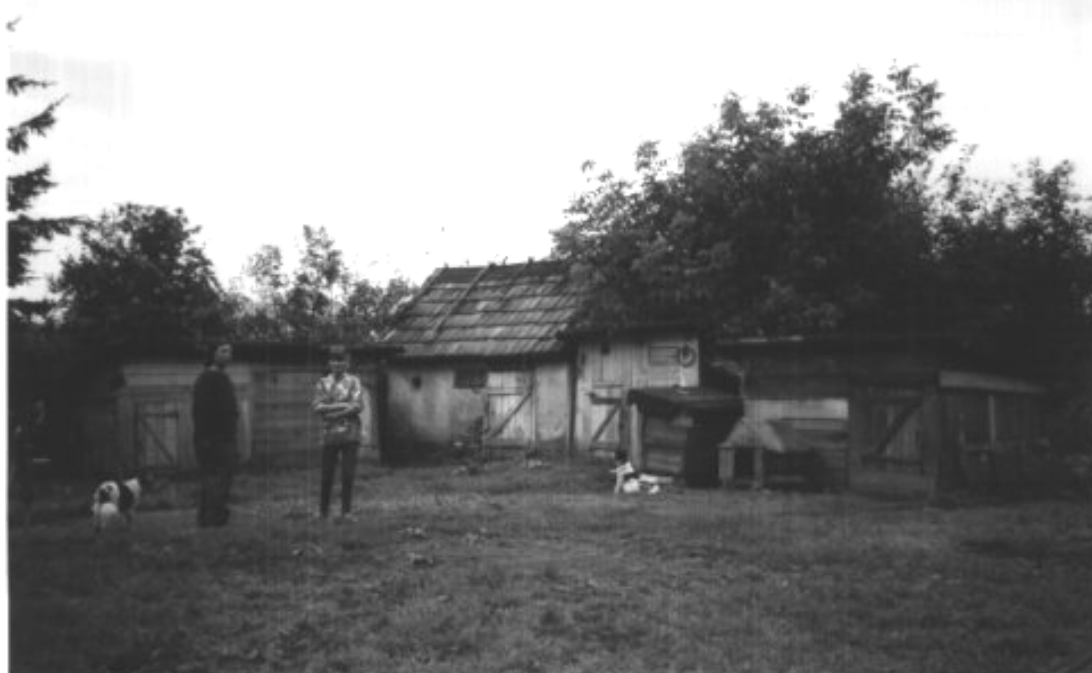
50. Hirtenhaus, Nebengebäude im Innenbereich, mit Stall für die Gemeindestiere
