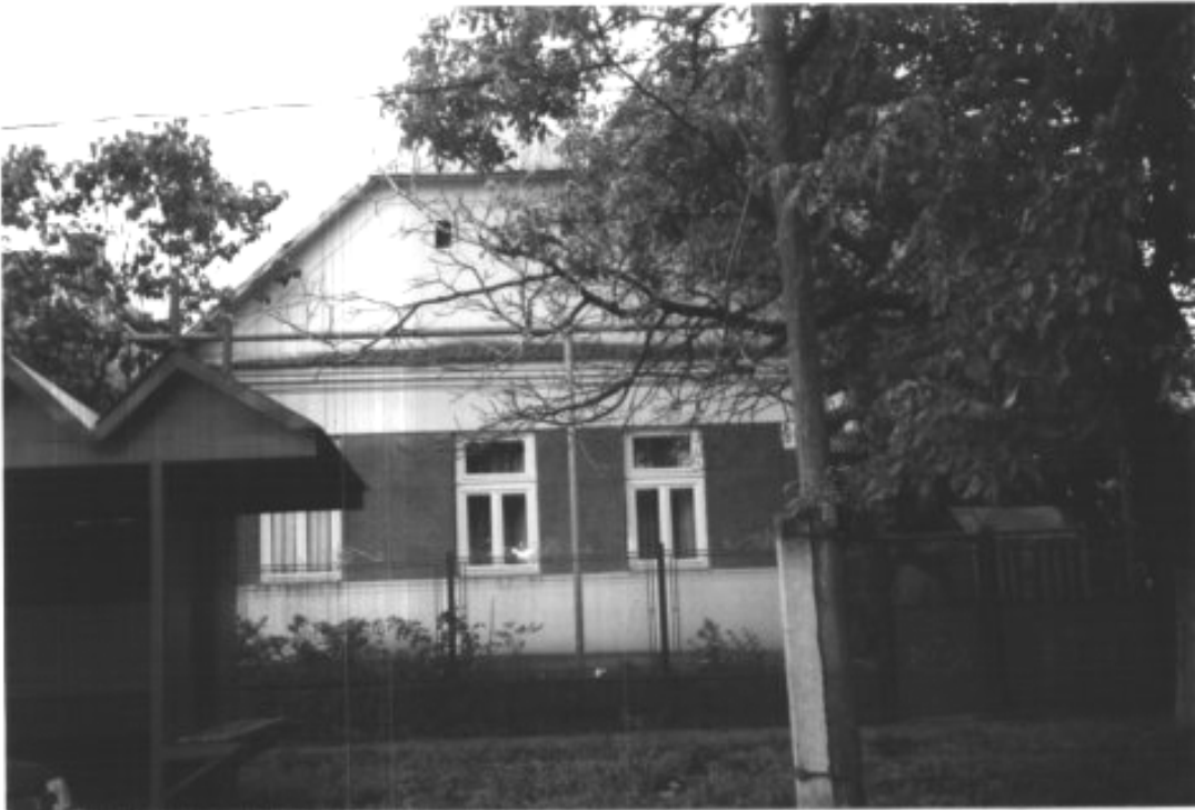
30. Ansichten des Wohnhauses Hauptstraße Nr. 92, Vorderansicht von der Straße aus
