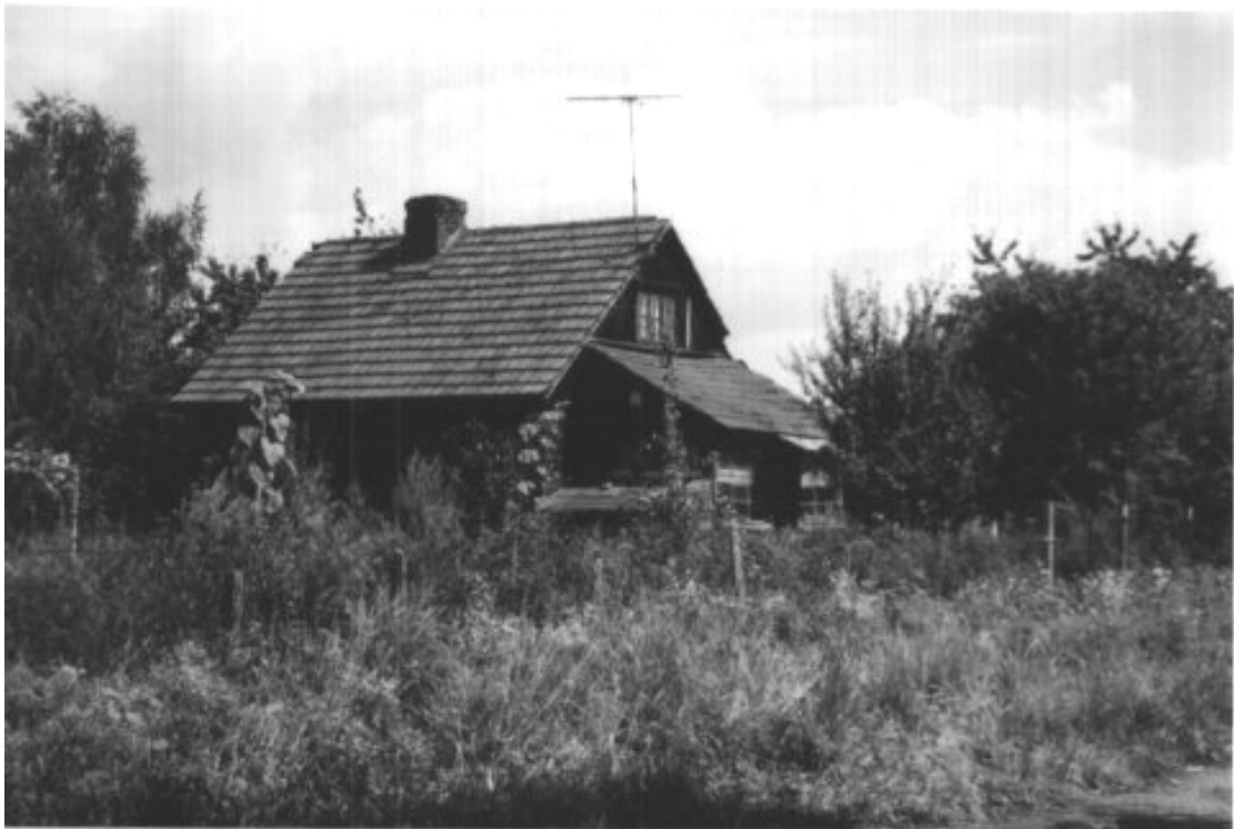
77. Ehemaliges Offizierswohnhaus am Rande des Kasernengeländes
