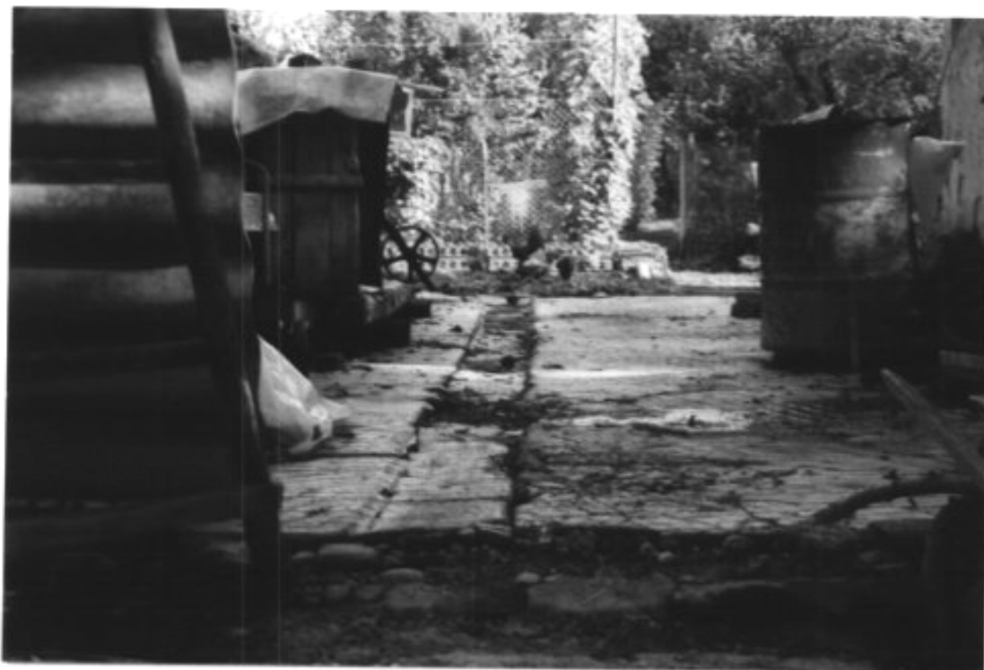
41. Betonboden des Viehstalls mit erkennbaren Abläufen in der Mitte
