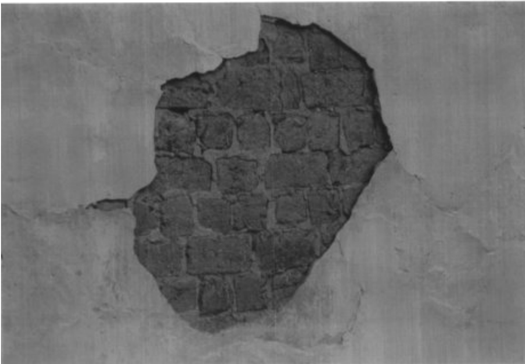
43. Walkenmauer des Wohnhauses
