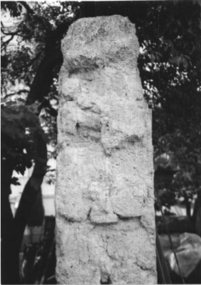
42. Walkenmauerwerk des Viehstalls (getrocknete Lehmziegel)
