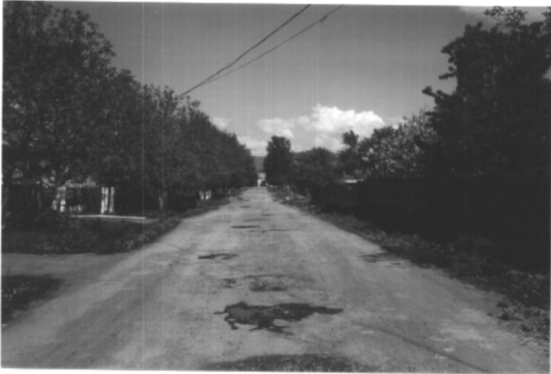
113. Kirowa-Straße in Richtung früherer Kaserne, jetzt Baustelle für das Seniorenwohnheim „Zentrum Nazareth“
