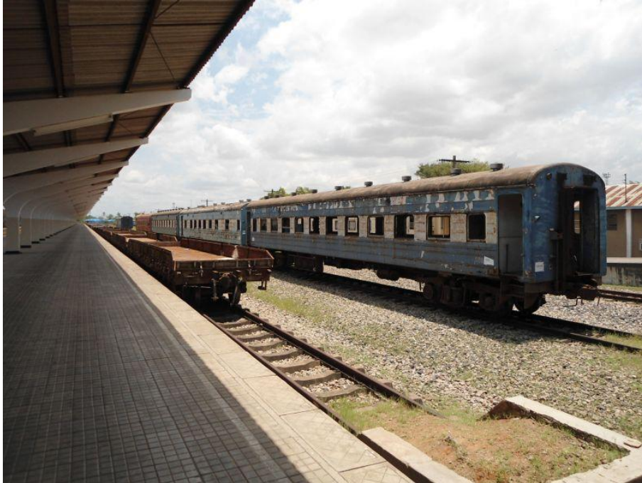
Der Bahnhof von Dar Es Salaam.
