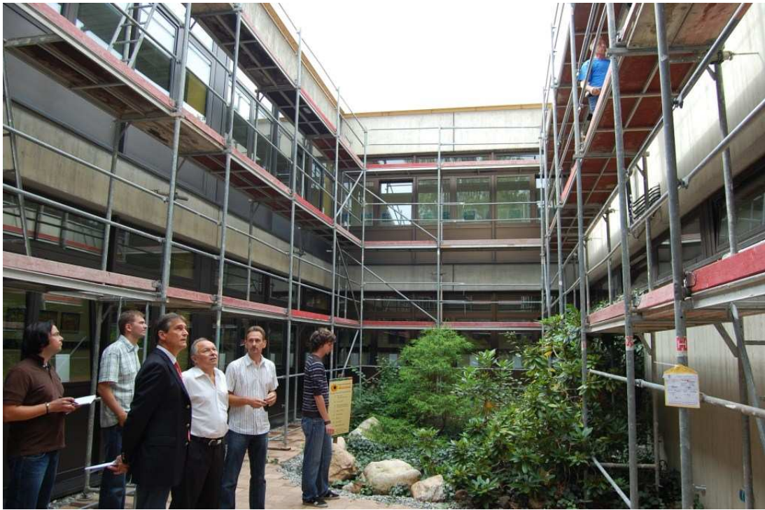
Bauarbeiten an der Volksschule Meyernberg.
