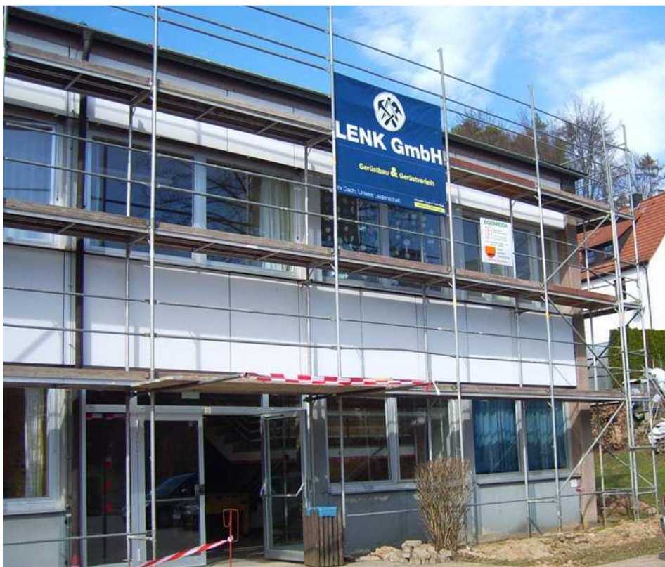
Die Grundschule Gößweinstein unmittelbar vor Beginn der Sanierungsarbeiten.
