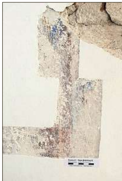
Ein Überbleibsel der originalen Wandbemalung im Wahnfried-Treppenhaus.
